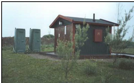
Gamla och nya toa. De nya sanitetsbyggnaderna försågs med tre vattentoaletter och en handikapptoalett i vilken det även fanns dusch.
